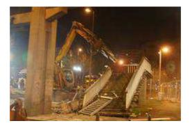
Disposition et mise en place des plots béton de 0.8X0.8X0.8 m posés sur tapis au pied de la passerelle et préparation des calage bois et tapis au sol (télescopique/pelle à pneu avec grappin).
