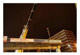
Broyage de l'escalier côté centre commerciale pour permettre plus d'aisance lors de la dépose de la passerelle.
